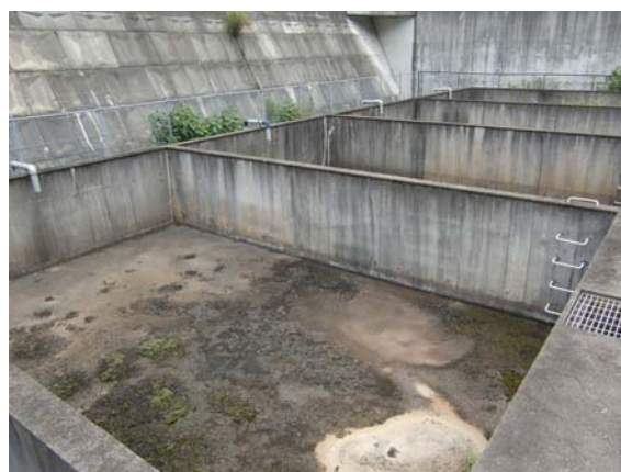
－ 浄水発生土（天日乾燥床） －
